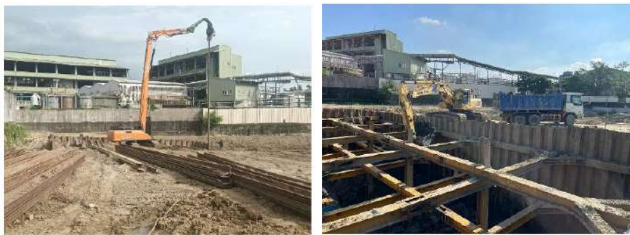
圖 4.2.3-11 那拔段場址整治作業執行情況
