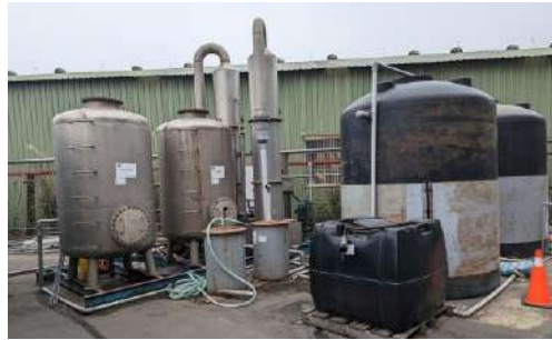
圖 4.2.3-6 東陽實業觀音廠場址整治作業執行情形
