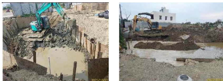
圖 4.2.3-22 育昇加油站整治區域執行情況
