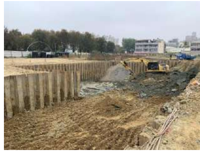
土壤開挖作業
