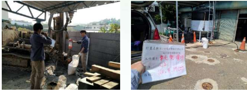
圖 4.2.3-16 景二公司場址整治作業執行情形
