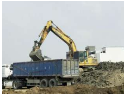
污染土壤裝載離場
